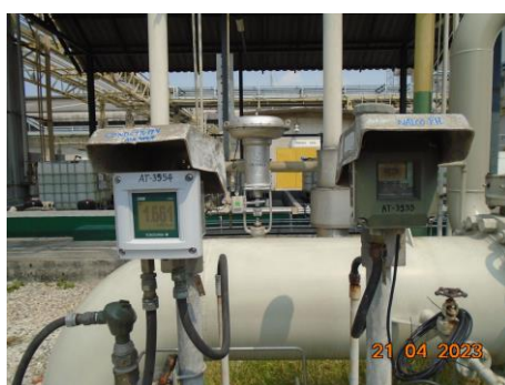
ภาพที่ 2.1-7 เครื่องตรวจวัดคุณภาพน้ำเสียแบบต่อเนื่อง ได้แก่ pH, Temperature, Conductivity (น้ำที่ระบายทิ้งจากระบบหล่อเย็น)
