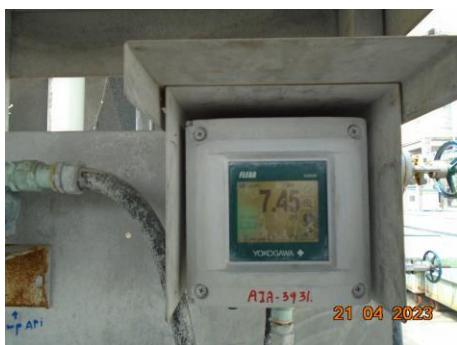
ภาพที่ 2.1-9 เครื่องตรวจวัดคุณภาพน้ำเสียแบบต่อเนื่อง ได้แก่ pH และ Temperature (น้ำที่ผ่านการบำบัดจาก API Separator Unit)
