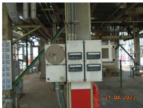
ภาพที่ 2.1-32 ตู้ Panel แบบป้องกันการเกิดประกายไฟ
