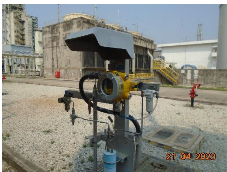
ภาพที่ 2.1-24 การติดตั้ง Gas Detector System บริเวณลานถังและที่เก็บสารเคมี
