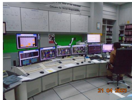
ภาพที่ 2.1-27 Distributed Control System (DCS)
