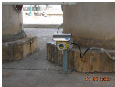
ภาพที่ 2.1-24 การติดตั้ง Gas Detector System บริเวณลานถังและที่เก็บสารเคมี
