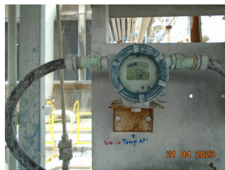
ภาพที่ 2.1-9 เครื่องตรวจวัดคุณภาพน้ำเสียแบบต่อเนื่อง ได้แก่ pH และ Temperature (น้ำที่ผ่านการบำบัดจาก API Separator Unit)
